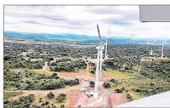
EOS-Ner exploite le parc éolien du Cers, à Conilhac, depuis 2003. PHOTO: GABRIEL
